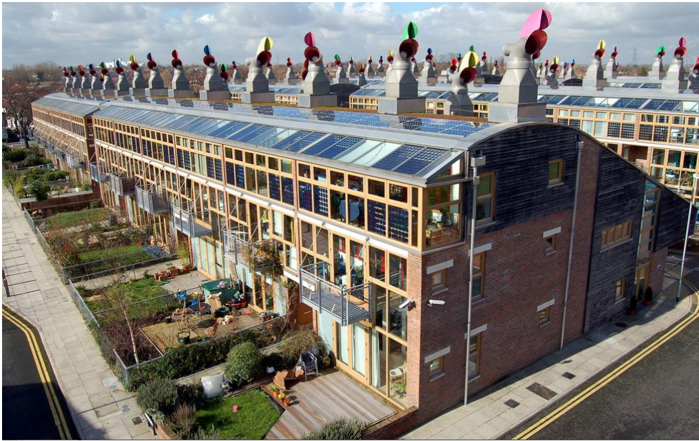
Figura 19 Vista do lado Sul de um lote BedZED, Londres, Inglaterra (BioRegional, 2009)
