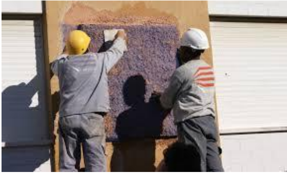
Figura 12 Isolamento das fachadas, no eco-bairro da Boavista (Bairro Boavista, 2014)
